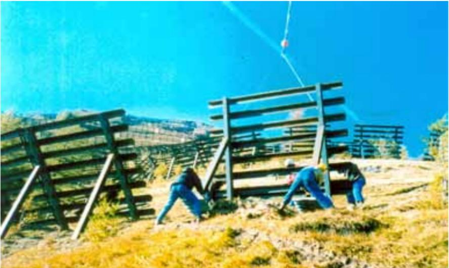
*Hubschrauber unterstützten die Errichtung der Lawinenanbruchverbauung (Stützverbauung) der Toldern- bzw. Toldernschrofen-Lawine östlich oberhalb des Ortsteiles Toldern im September 1997.*
