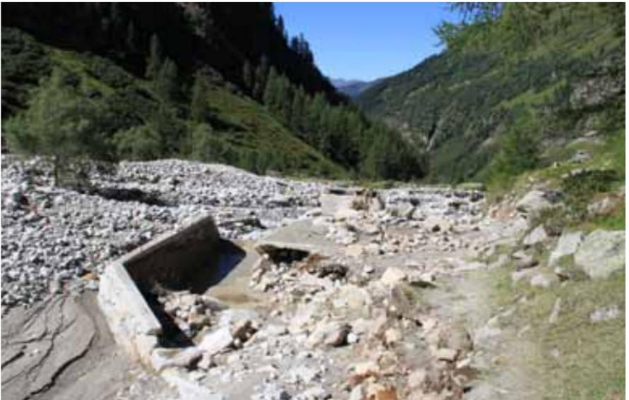
*Die Talstation der Materialseilbahn zur Geraer Hütte wurde im August 2012 durch eine Mure zerstört und musste neu errichtet werden.*
